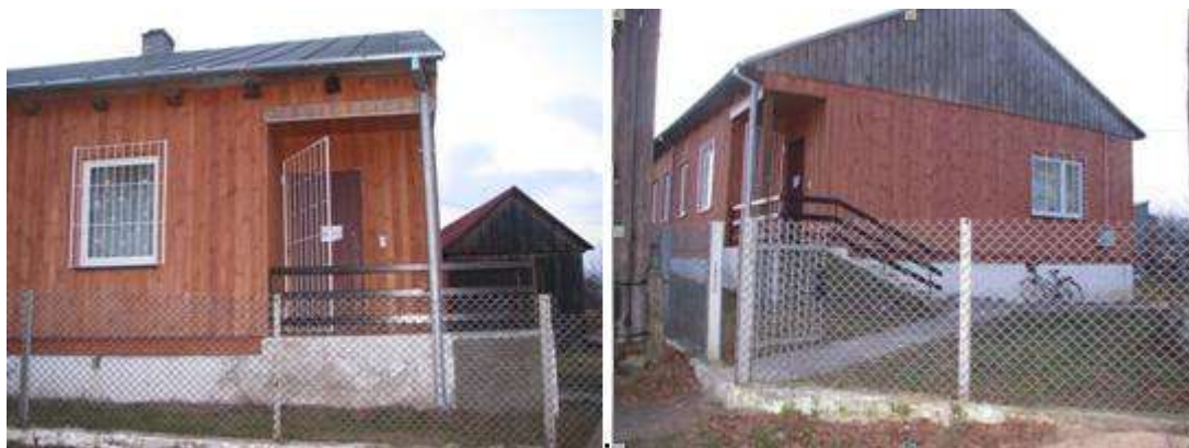
Fot. 17,18. Świetlica wiejska w Lipie. Fot. Halina Szymańska.
