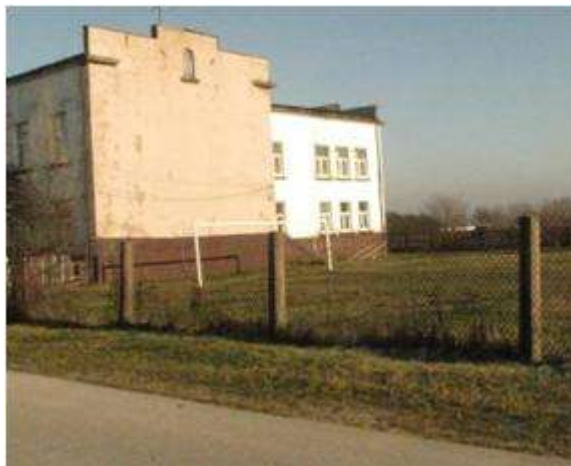
Fot. 21. Brak chodnika wzdłuż drogi, którą uczęszczają dzieci do szkoły.
